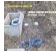
Фото 1. Установка датчиков давления на грунт
